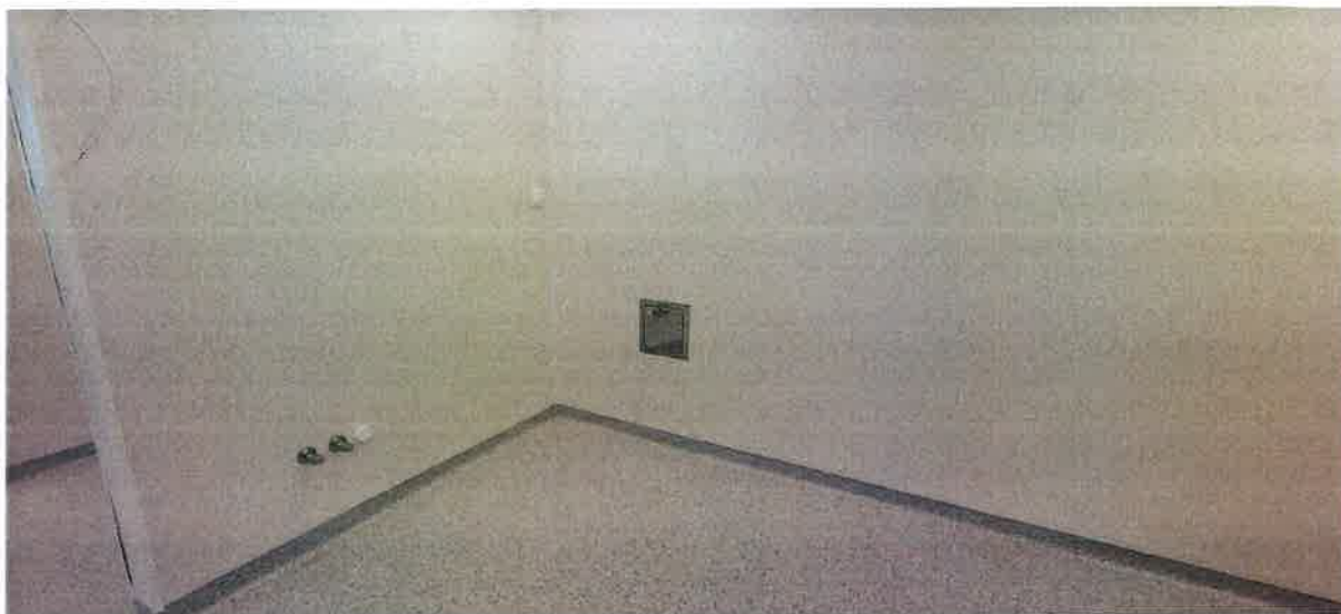
FOT. 1. Zdjęcie drzwiczek rewizyjnych przy stanowisku do zmywania B5/B5.1
